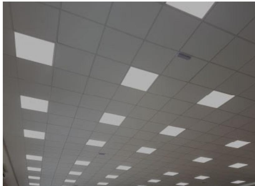
Para todo o auditório está sendo proposta a instalação de luminárias de painel de led do tipo embutir, esta tem a função de plena luminosidade de todo o espaço. Conforme especificações e devido ao modulo do forro mineral, a luminária ideal é o painel com dimensões de 62cm x 62cm.
